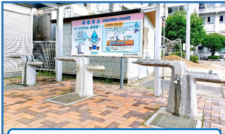
水道管直結給給水方式の水飲み場「のめるん」
